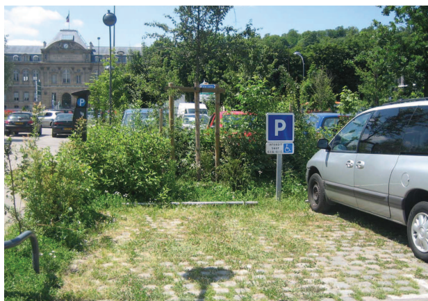
Stationnement de véhicules au sol perméable
