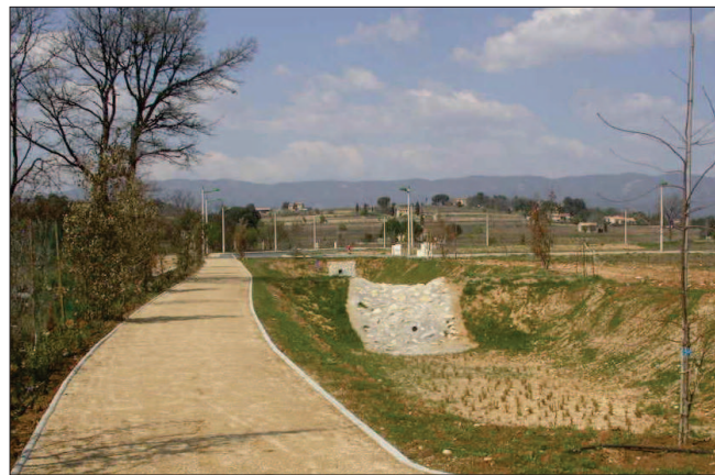
Voie d'entretien et bassin de rétention
